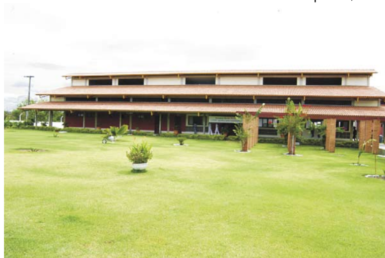
Unidade, que foi reformada, tem capacidade para 350 leitos
