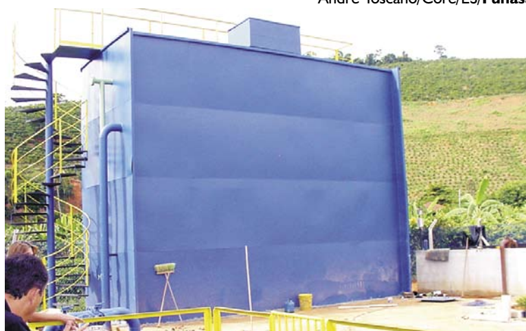
Nova estação de tratamento de água já está operando
